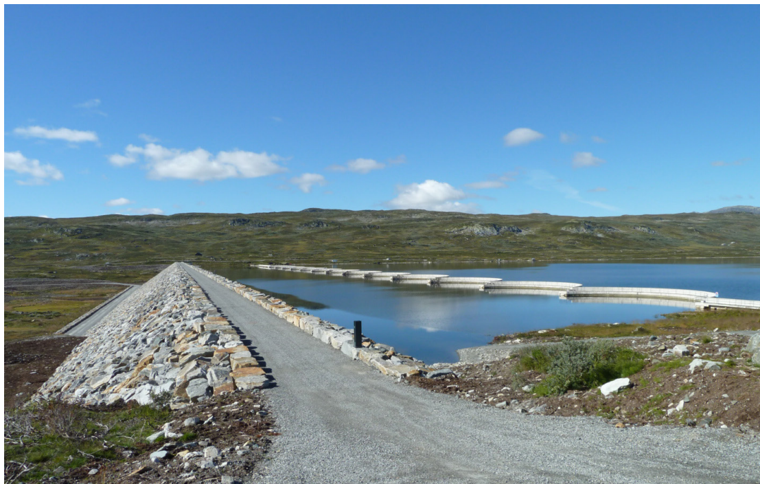
Dam Stolsvatn. Foto: Jon Atle Eie.
